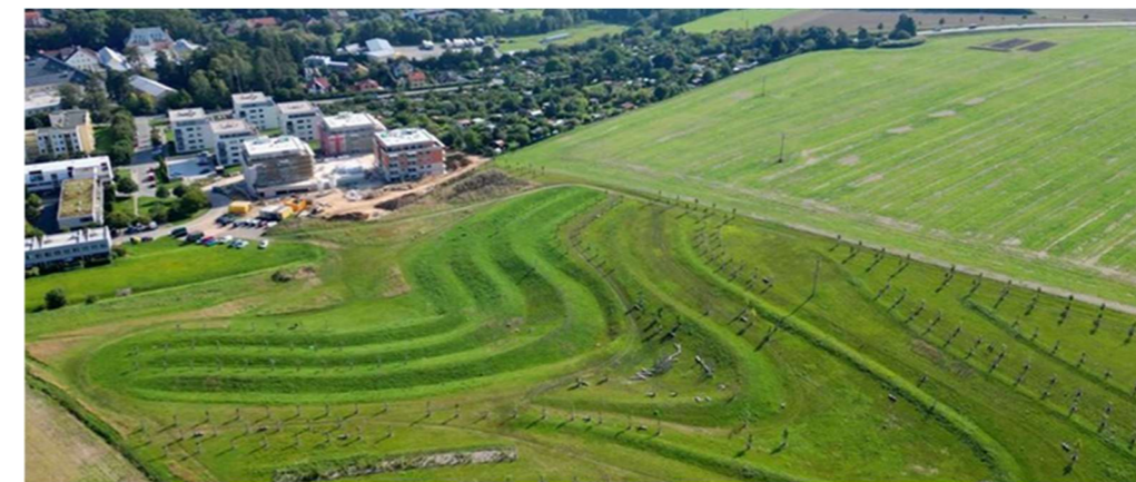
Ukázka systému průlehů a výsadeb v Litomyšli dal vzniknout novému parku Zdeňka Kopala, který tak nahradil technický suchý polder a ochraňuje zástavbu od vody přitékající po odtokové linii z okolních polí. Litomyšl, autor: krajinářská architektka Eva Wágnerová. Zdroj: Vojta Herout, Adapterra Awards.
