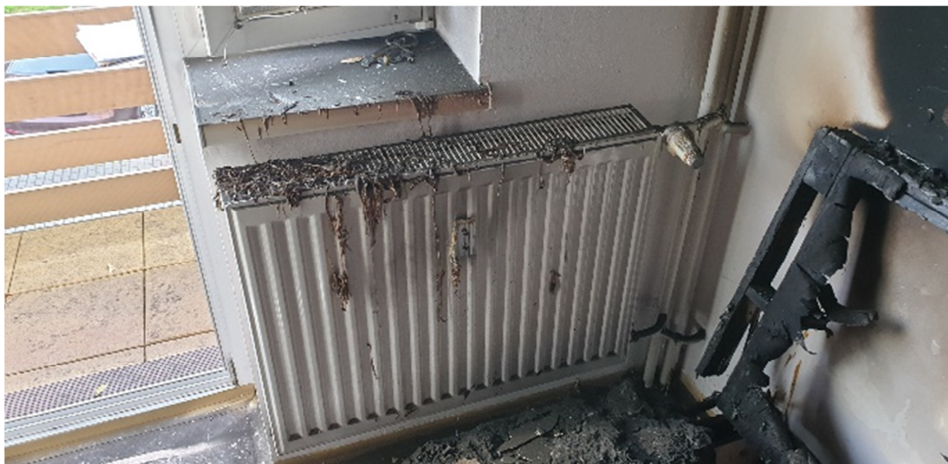
Místnost 206 - poškození radiátoru, plastových vnitřních parapetů, žaluzií
