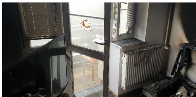
Místnost 206 - poškození radiátoru, plastových vnitřních parapetů, žaluzií
